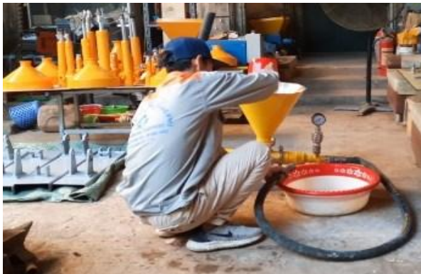
Đổ nước và bơm để đẩy hết vữa ra ngoài
