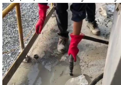
Bơm chính, đặt vòi bơm vào vị trí cần bơm
