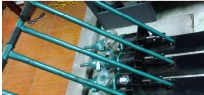
Đẩy hết hành trình pitton về phía trước sau khi vệ sinh thiết bị
