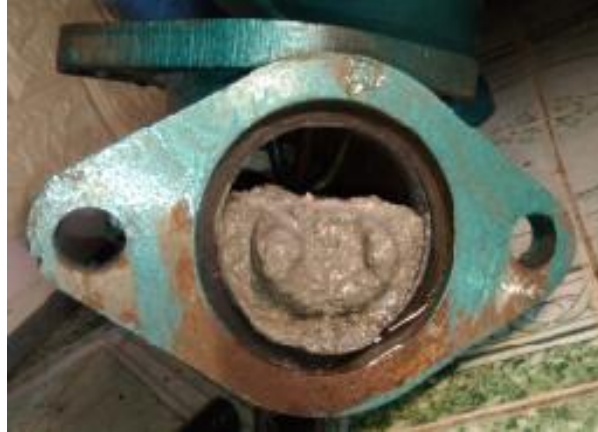
Dùng khoan bê tông vệ sinh khi vữa đóng đóng chặn thân bơm
